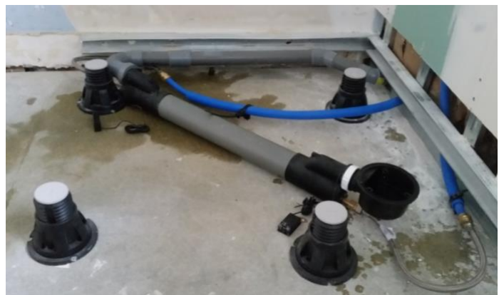
Installation sous le receveur de douche
