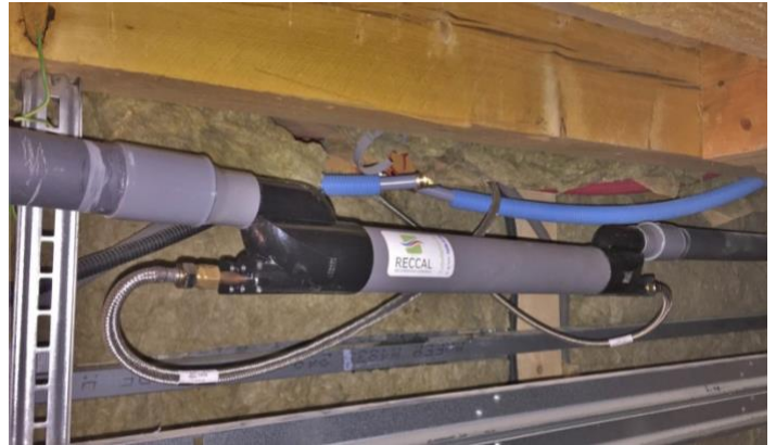
Installation en sous-sol
